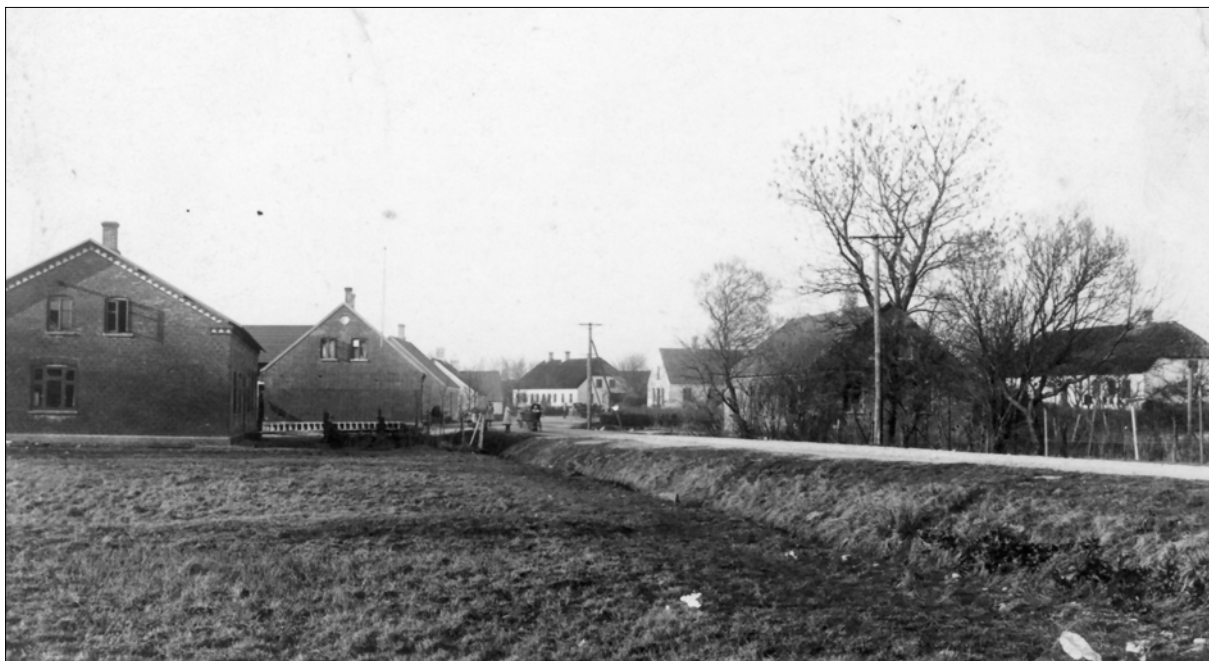
Samlinghuset længst til venstre. Læg mærke til vejgrøften, der først rørlagdes 1930
