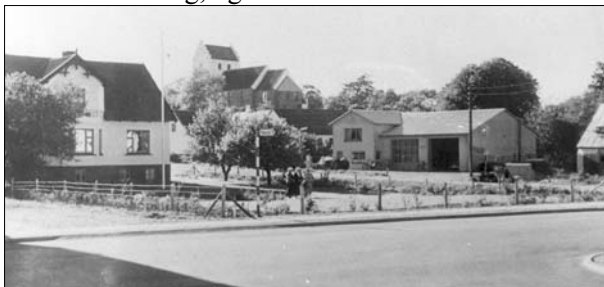
Autoværkstedet til højre
