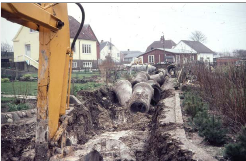
Smedevænget under total opgravning 1964
