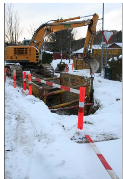
Gravning i sne og frost på Estrupvej
