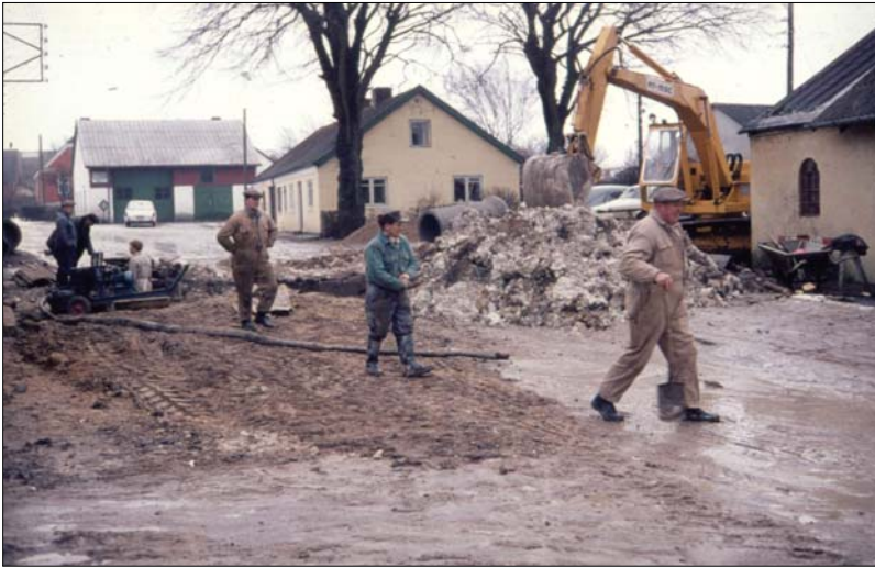
Opgravning på Øster Hornumvej 1964
