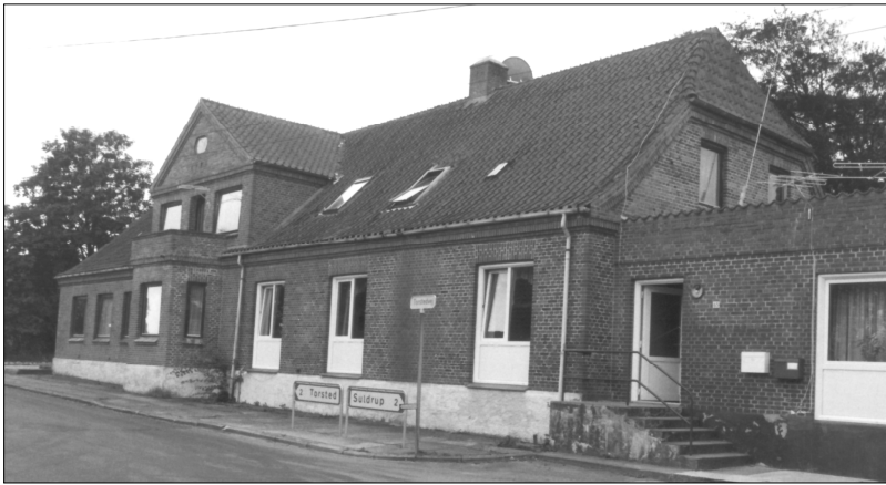
Den nu nedlagte købmandsbutik i Torsted Mølleby, hvor der kunne købes det fornødne for at drive en skole
