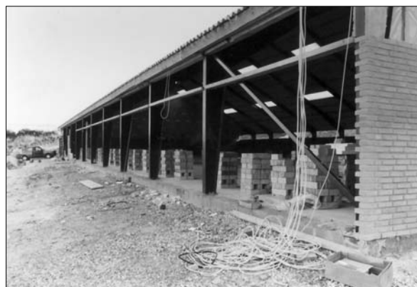
Hallen under opførelse 1984
