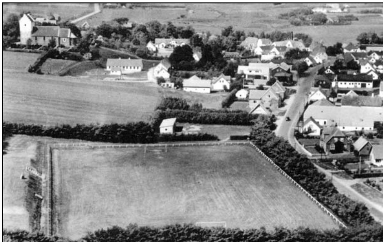
På dette luftfoto fra 1954 ses Anders Vævers gård i midten yderst til højre. Det var i det lille hus lige foran, Søren Peter blev født 1919
