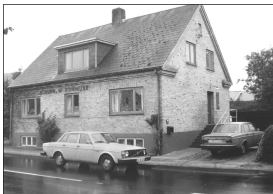
Kommunekontoret i Øster Hornum efter det i 1970 var overgået til privat bolig
