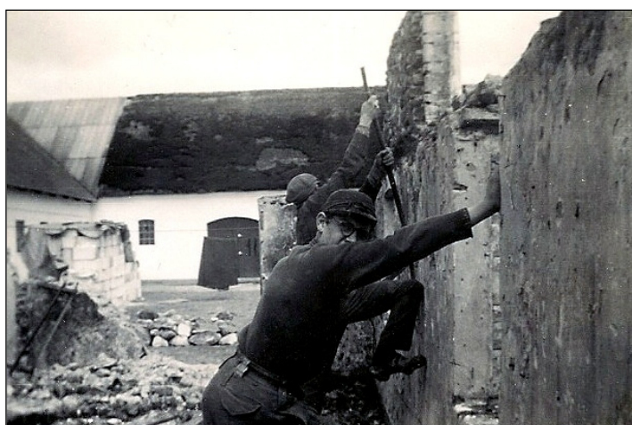
Det gamle stuehus brydes ned
