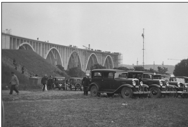
Allerede mens Lillebæltsbroen var under opførelse, var den et velbesøgt udflugtsmål
