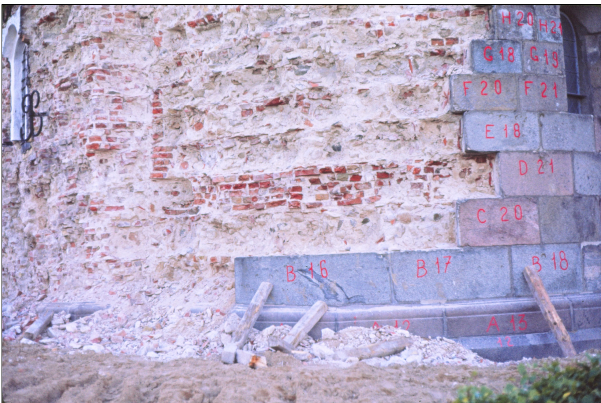
Teglstenene er brugt som murkerne ved en ommuring i 1700-tallet
