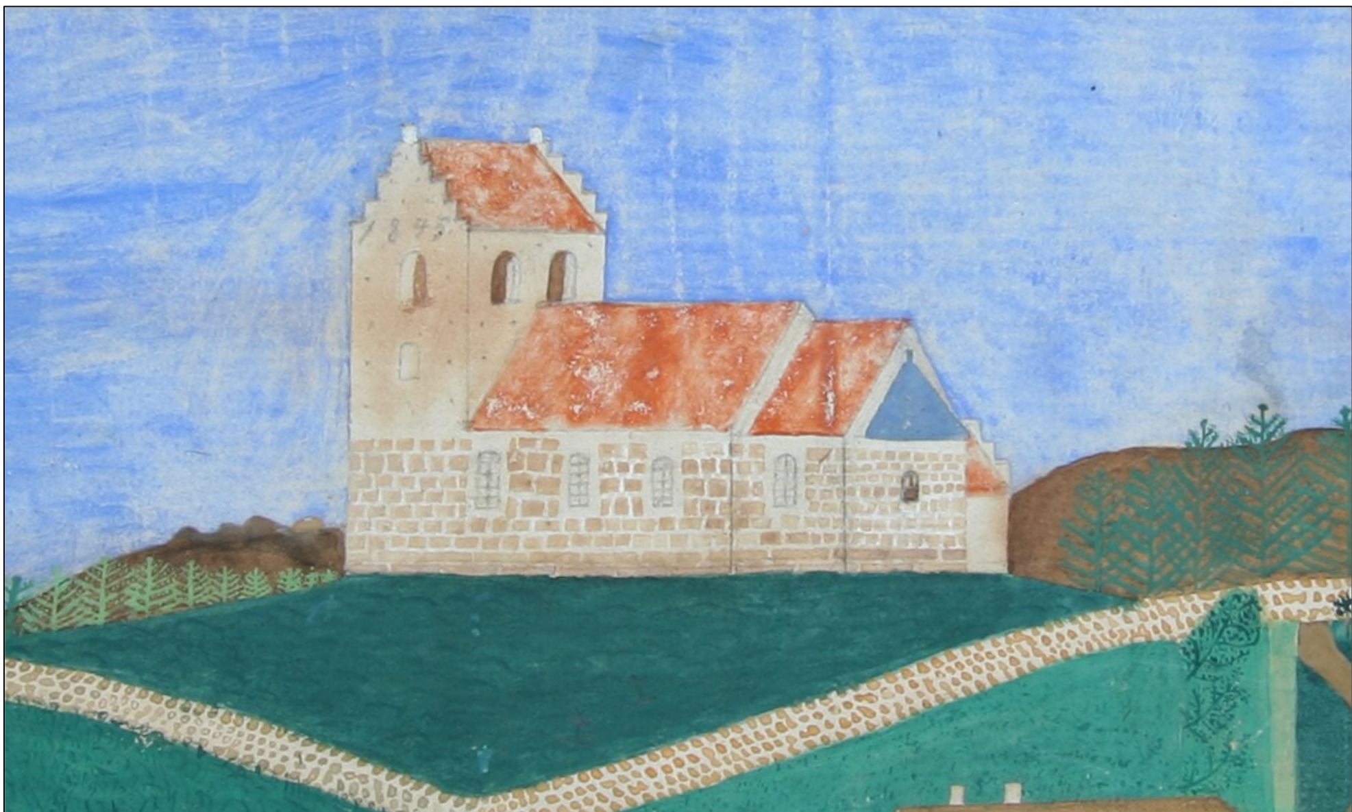
På et tidspunkt, måske i 1500-tallet blev der sat lidt større vinduer i mod syd
