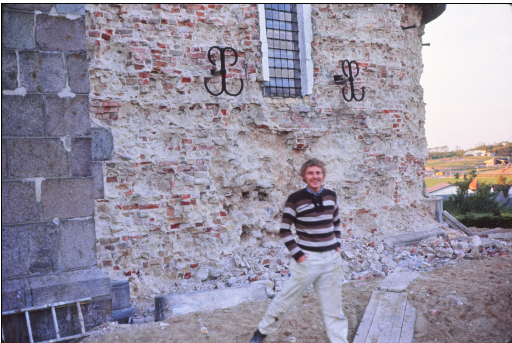
Kvadrene er taget ned, og murersvend Søren Thrysøe er klar til at medvirke til at de sættes på deres rette plads
